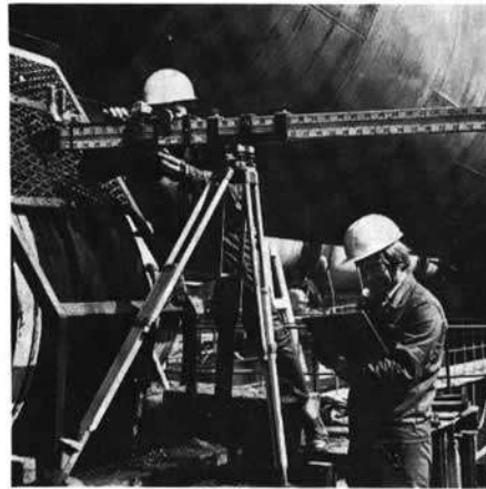
Bild 7: Das „Piecometer“ beim Messen Piecometer alignment measuring apparatus in use
